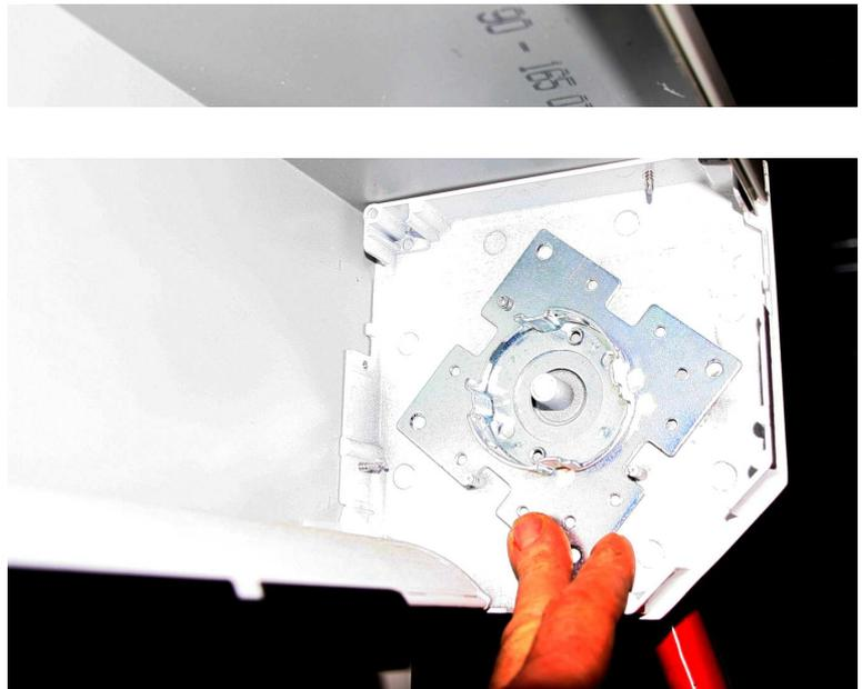
Préparer le tube d'enroulement à la longueur du coffre, au besoin recouper le.
