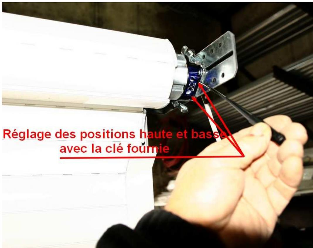
Vérifier la montée et la descente du volet roulant, ensuite vous pouvez remonter le coffre et réaliser le raccordement électrique définitif.
