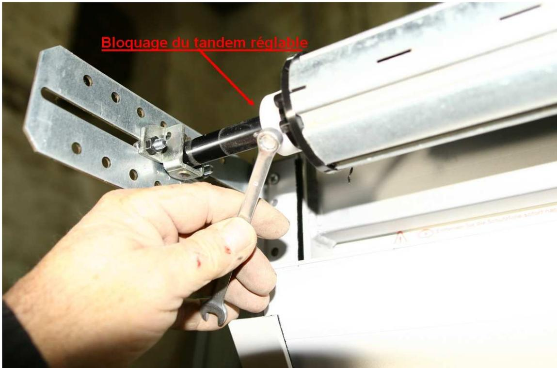
Raccorder le moteur sur l'inverseur mécanique
