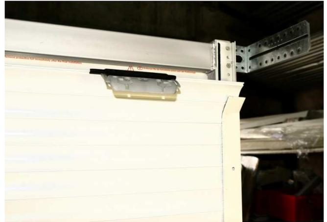
Dépose du tube d'enroulement existant et des supports sur coffre tunnel
