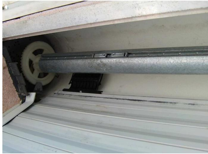
Dépose du tube d'enroulement existant et des supports sur coffre traditionnel
