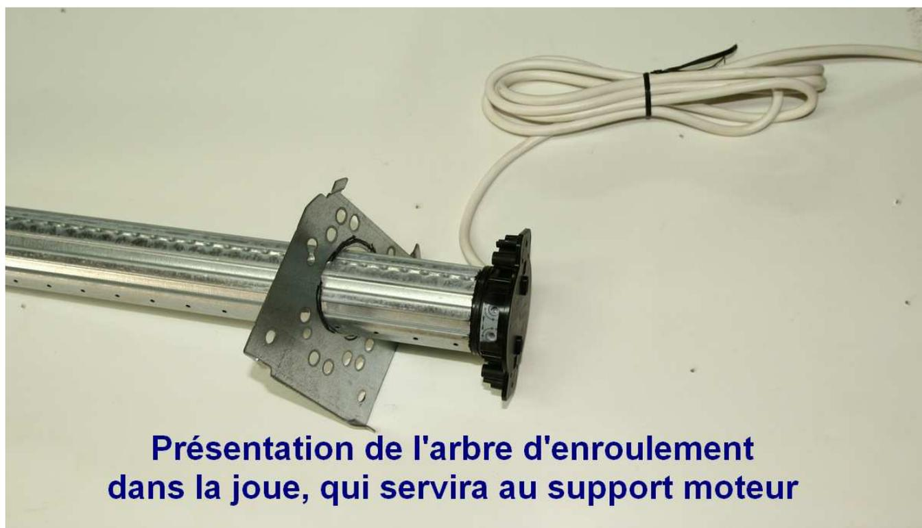
Mise en place du tube d'enroulement dans le coffre.
