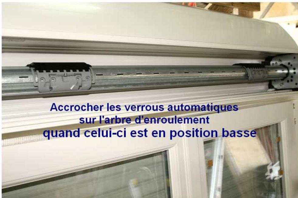
Faire ensuite un appui sur l'inverseur jusqu'à la position haute du volet. Il est possible que la position haute soit supérieure à celle de votre volet, dans ce cas, redescendre le volet et réduisez sa course en diminuant la montée à l'aide des vis de réglage de fin de course haute.
