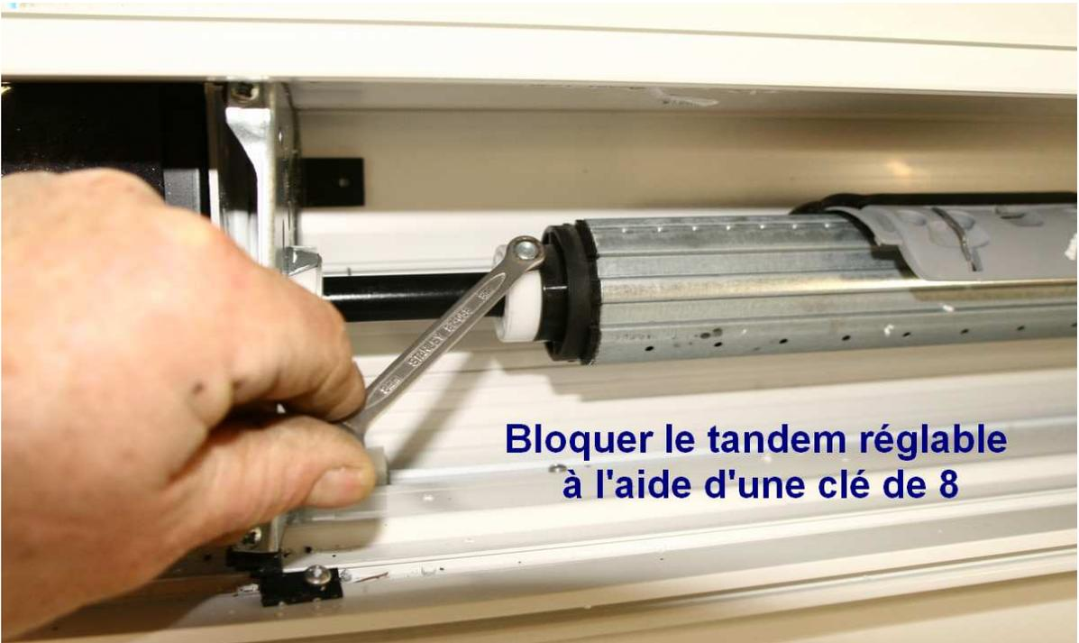
Raccorder provisoirement le moteur à l'inverseur mécanique, sur une fiche mobile, et faire un appui sur descente et mettre le moteur en position basse, avant d'accrocher le tablier
