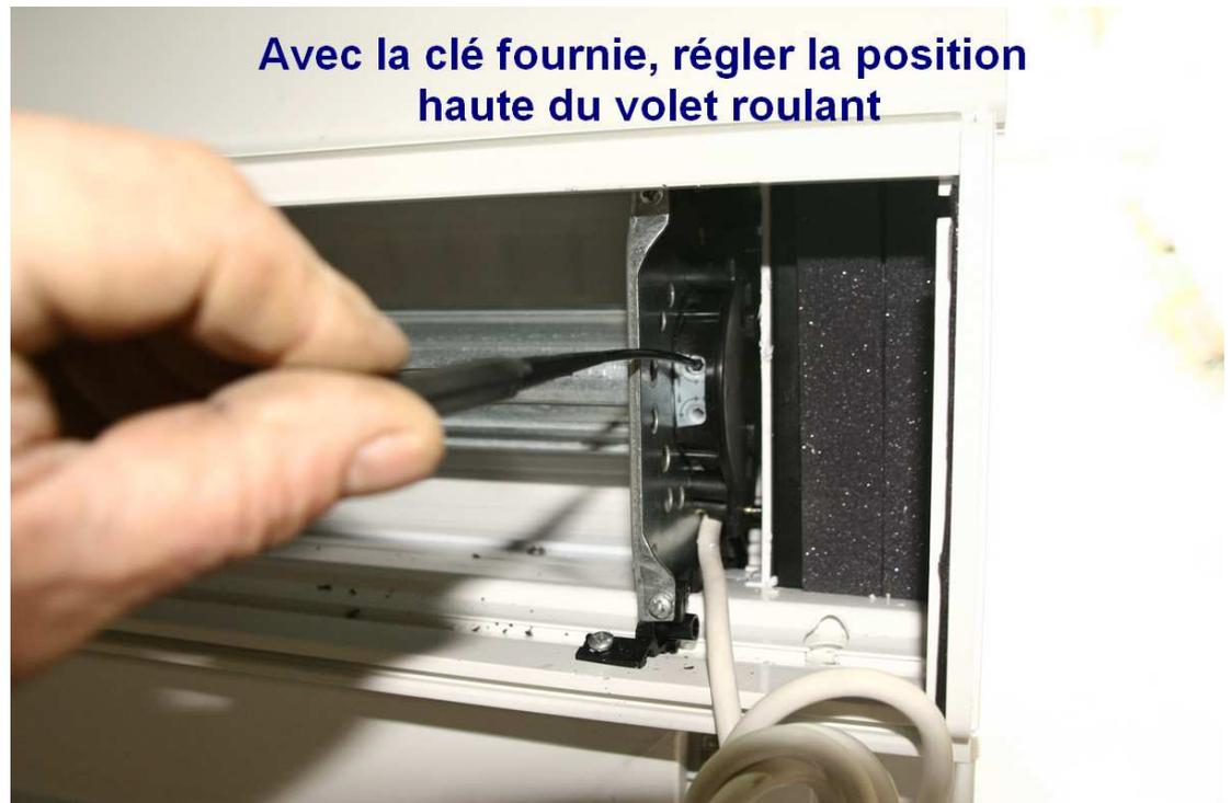
Vérifier la montée et la descente du volet roulant, ensuite vous pouvez remonter le coffre et réaliser le raccordement électrique définitif.
