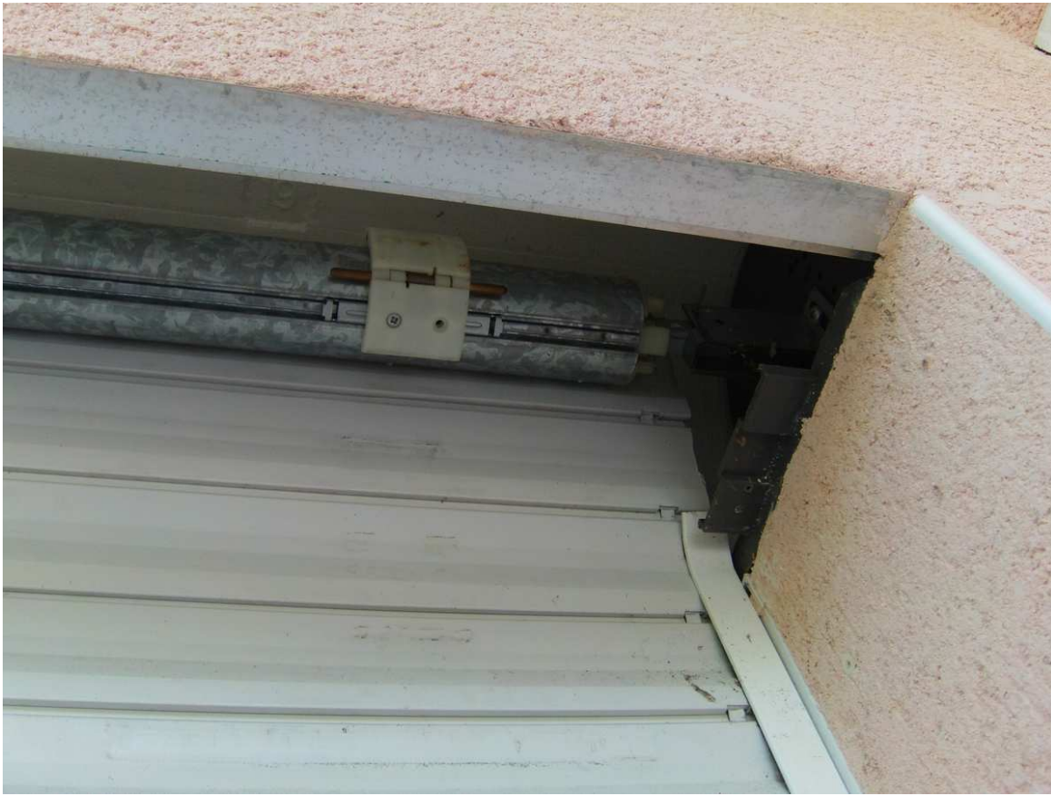
Coté opposé à la manœuvre
