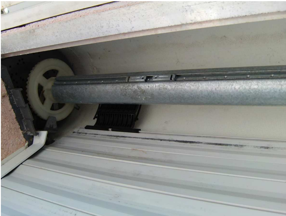
Libérer l'axe des verrous et sangles d'entraînement du tablier
