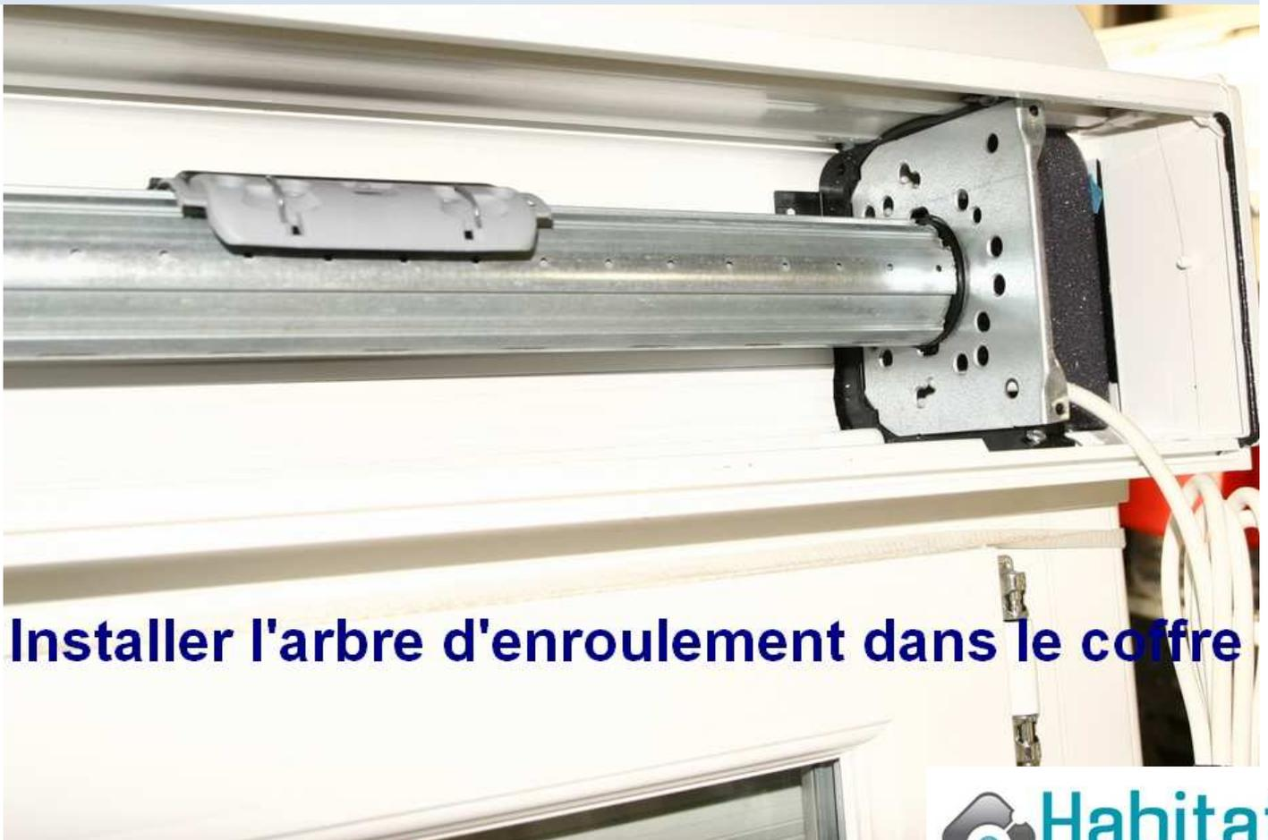
**Installer l'arbre d'enroulement dans le coffre**
