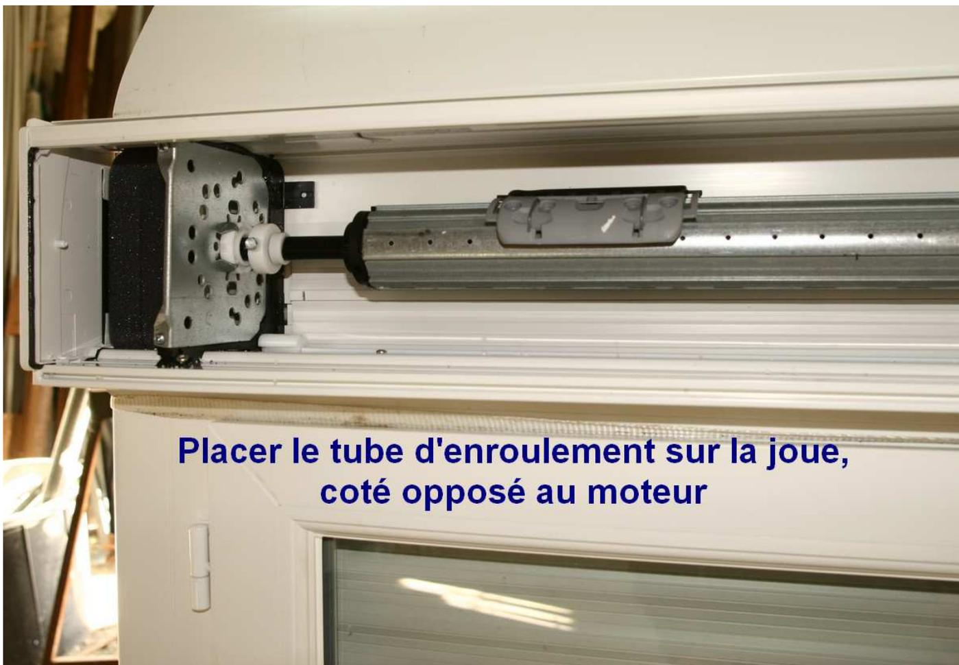
**Placer le tube d'enroulement sur la joue,
