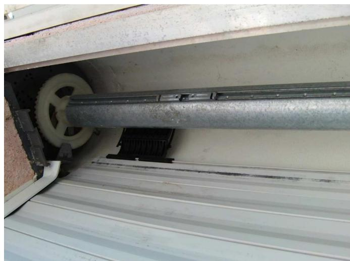
Dépose du tube d'enroulement existant et des supports
