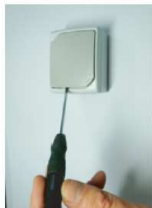
2.1) Déclipez le bouton poussoir de l'interrupteur émetteur.
